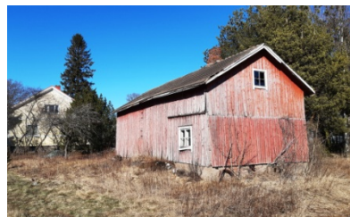
Piharakennus 2 sijaitsee Kreulantien vieressä pääty kadun suuntaan.
